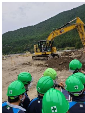
建設重機見学 （ICT 施工）
