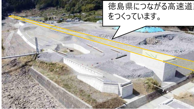
北川道路（北川村和田）（ICT 施工※）
