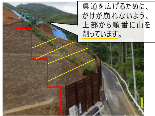
県道南国伊野線工事（高知市鏡）（ICT 施工※）
