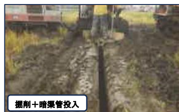
トレンチャー工法による暗渠排水工の施工イメージ
